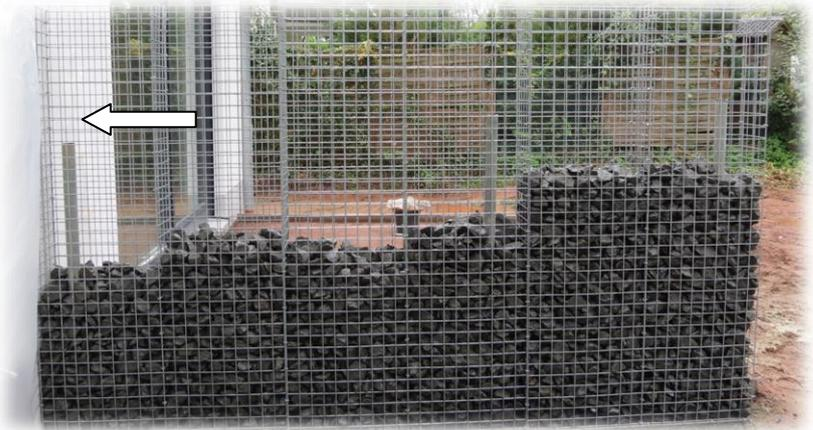
Überprüfen Sie beim Aufstellen mit einer Wasserwaage, ob die Gabione im Lot steht. Auch die Pfosten sollten senkrecht nach allen Seiten waage eingefügt sein, ansonsten gibt es oben an der Pfostenspitze Schwierigkeiten, Steine zu hinterfüllen (siehe Pfeil im Bild).
