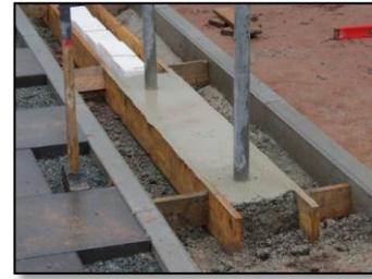
Das Streifenfundament dient lediglich als Sauberkeitsschicht und trägt die Last der Gabione ohne Bedenken. (Aufbau bis 2,00 m, Breite 0,22 m)
