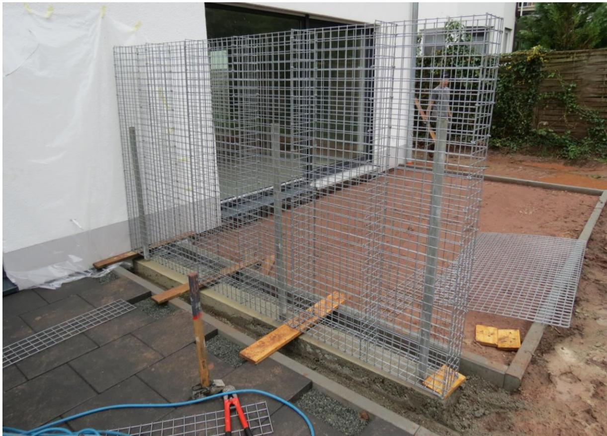
Die Stützpfosten werden so gesetzt, dass ein Abstand zwischen Wand und Pfosten entsteht, um den Steinen genug Platz zu lassen. Somit wird die **Bodenmatte** wie folgt ausgeschnitten:
